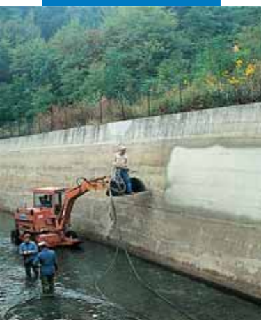
Нанесение Idrosilex Pronto напылением на подводный канал гидроэлектростанции
