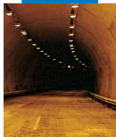
Нанесение белого Idrosilex Pronto напылением в автодорожной галерее
